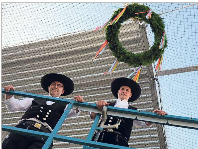
Im nächsten Schritt wird das Dach gedeckt: Zimmerer Stefan Stamm (links) vom gleichnamigen Delbrücker Unternehmen und sein Kollege Ludger Schlepper brachten den Richtkranz an. Foto: Bussieweke
